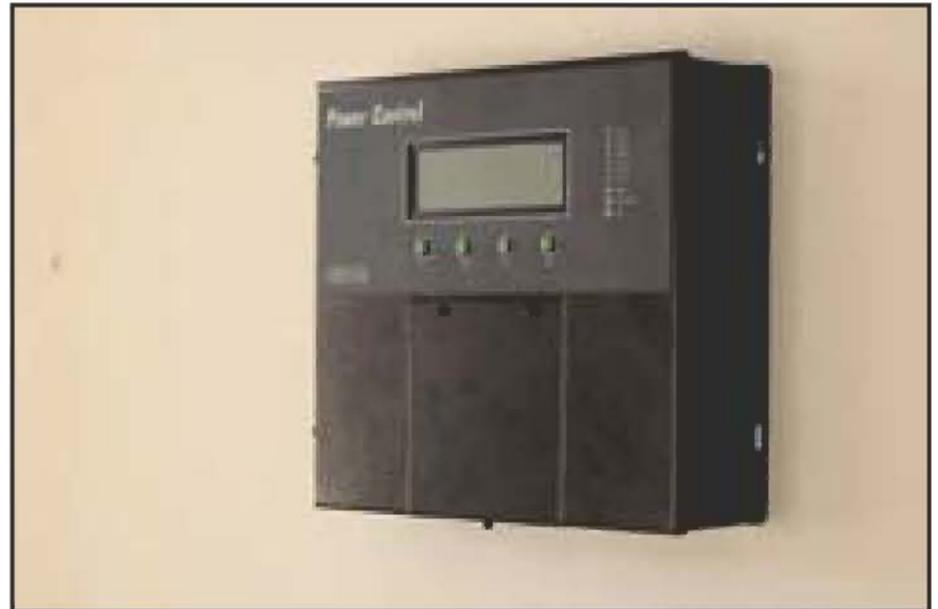
L'operatore può impostare i messaggi che desidera ricevere, inoltre può richiedere mediante SMS lo stato dell'apparecchiatura visualizzando il prelievo dei 15' precedenti, l'istantanea e il consumo previsto nei 15' in corso, ed eventualmente resettare allarmi.
